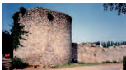
Vestige de la tour dite aussi « Tour à l'âne » (photo 2002).
